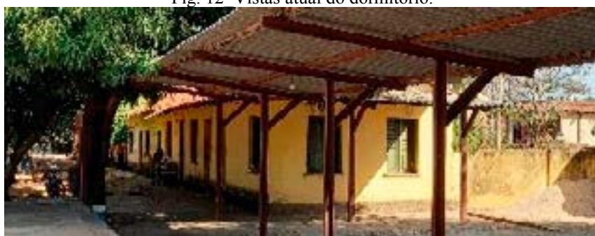
Fig. 12 Vistas atual do dormitório.
