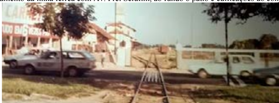
Fig. 13_ Cruzamento da linha férrea com Av. Frei Serafim, ao fundo o pátio e edificações do conjunto. Dec. 80.
