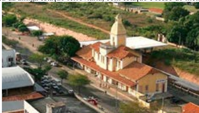
Fig. 15_Vista aérea da antiga estação ferroviária, com estação e fosso do metrô e pátio ao fundo.
