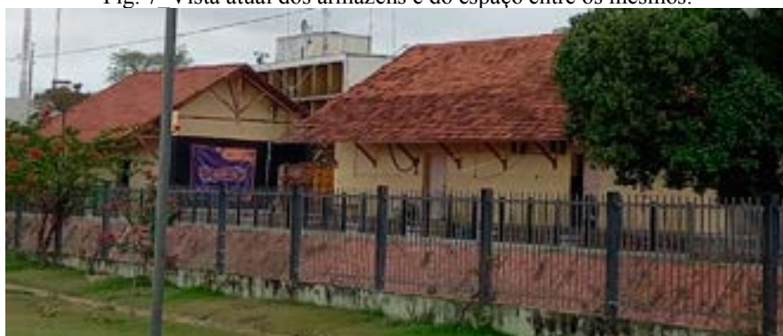
Fig. 7 Vista atual dos armazéns e do espaço entre os mesmos.
