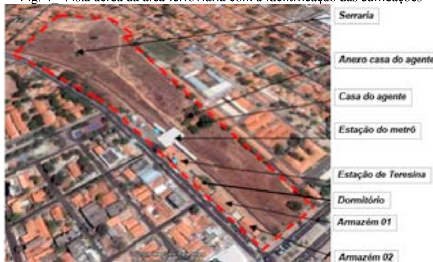
Fig. 4_ Vista aérea da área ferroviária com a identificação das edificações
